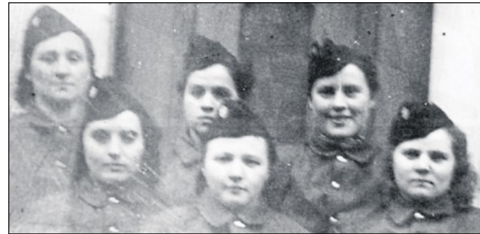
TATKRÄFTIG verhinderte die Mädchenriege, dass nach einem Flugzeugabsturz andere Gebäude abbrannten. Foto: pr
